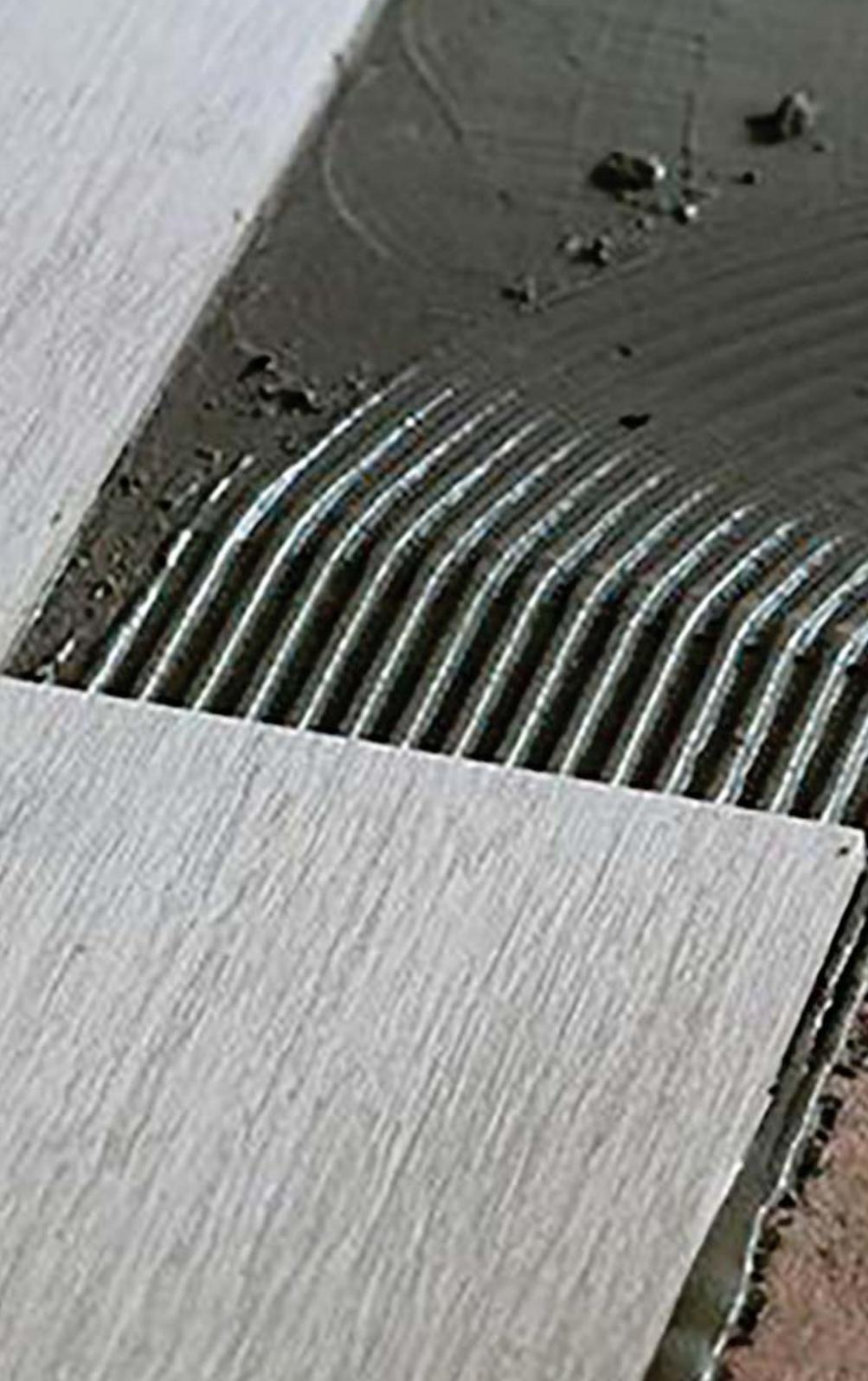
**PREPARAZIONE DEL SUPPORTO** Le superfici destinate all'applicazione della **COLLA TERMICA NANOTEK** devono essere pulite, asciutte, sgrassate senza crepe ed esente da alghe. Prima dell'applicazione, si consiglia di reintegrare se necessario i difetti dei materiali e primerizzati con prodotto **ALLPRIMER** dedicato
